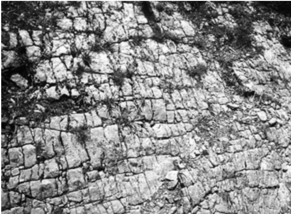
Figure 1 Réseau de diaclases sur les dalles de marno-calcaires du Berriasien inférieur du flanc ouest de l'anticlinal du couvent, au Col de la Ruchère. Joint set on the structural surface of shaly limestone lower Berriasian on the west flank of the convent anticline, near the Col de la Ruchère.
